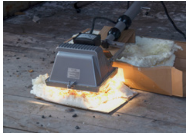
Halogenlampe på byggsaum.
