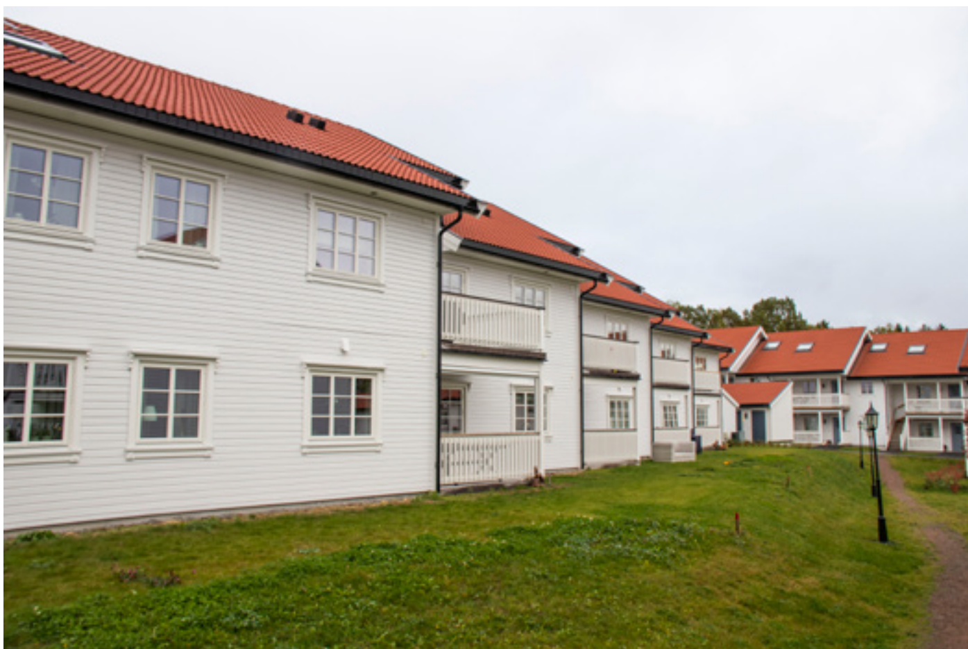
Det er blant annet rømning fra soverom i tredje etasje som er problemet.
