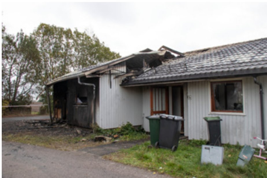
Grunnet manglende brannskiller på loftet spredte brannen seg til naboleiligheten.
